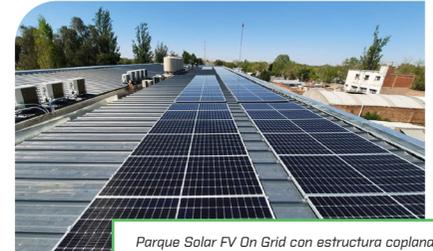
Parque Solar FV On Grid con estructura coplanar de 37,80KWp sobre techo para autoconsumo de Colegio UCA, Mendoza, Argentina.
