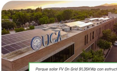
Parque solar FV On Grid 91,35KWp con estructura soporte de paneles solares Steel Framing para autoconsumo en UCA sede Mendoza, Argentina.
