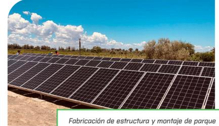
Fabricación de estructura y montaje de parque solar FV on Grid 28,08KWp para riego de vid departamento de Caucete, San Juan.
