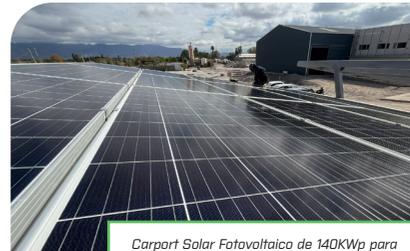
Carport Solar Fotovoltaico de 140KWp para autoconsumo en planta de elaboradora de hormigón, taller metalúrgico y edificio administrativo.
