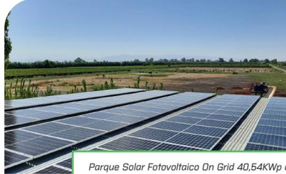
Parque Solar Fotovoltaico On Grid 40,54KWp con estructura coplanar Bodega Marchio y Meglioli
